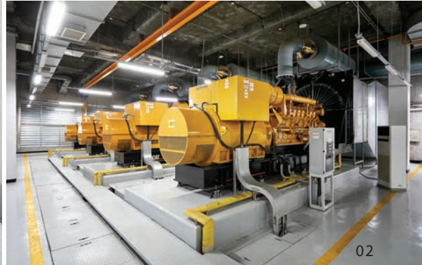
02 강원랜드에는 주요 시설의 예비 전력으로 캐터필라 2,000kW급 디젤 비상 발전기 10대가 설치돼 비상시 또는 예고 정전 시 강원랜드 전체 시설의 부하를 100% 커버하고 있다.
