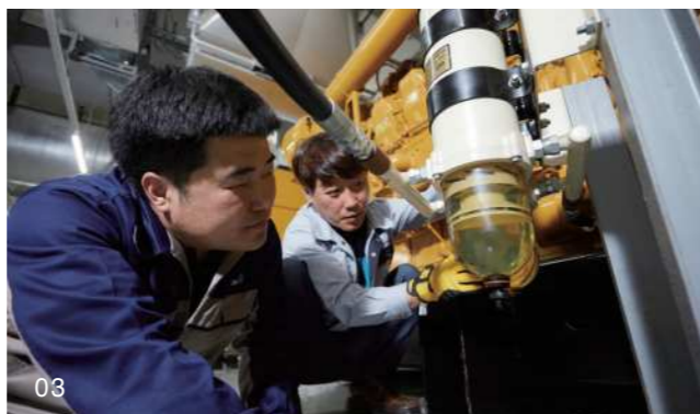
02 캐터필라 비상발전기 3516B는 창원경상대학교병원 시험 가동 결과 장시간동안 정격용량의 100%를 가동해도 안정적인 전력 공급이 가능했다.
